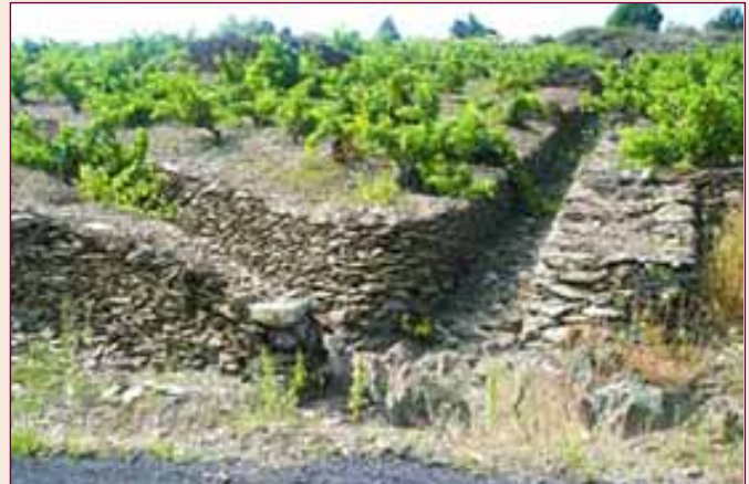
Détail de collecteurs utilisant des pierres sèches
